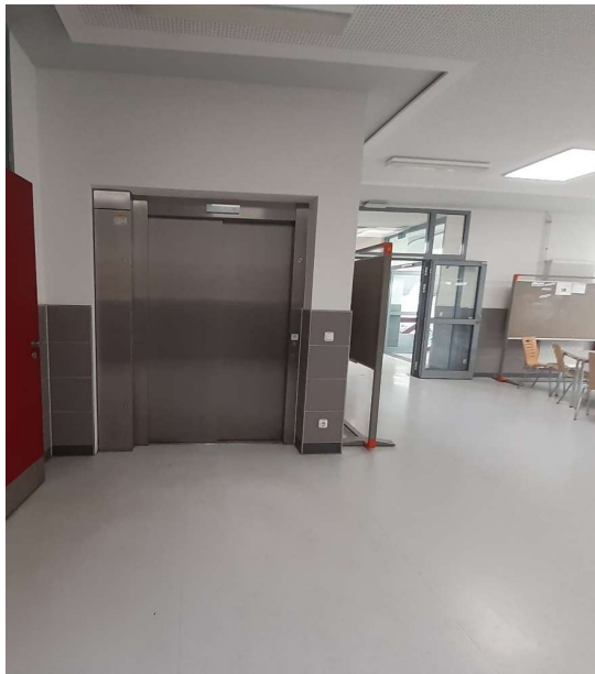
Im oberen Flur laufen viele oft an dieser Tür vorbei...
